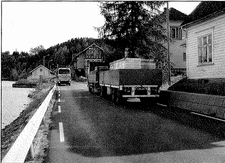
En hyppig situasjon på Lanna. To tungtransportbiler møtes på den smale veien. Rystelsene i husene rundt er ødeleggende for den gamle bebyggelsen.
